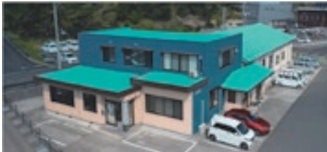
本社事務所(外観)
