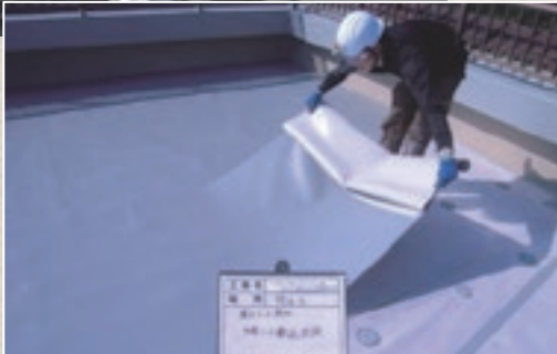
塩ビ系シート防水施工
