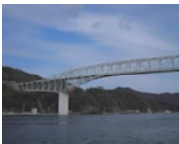
国道431号 境水道大橋 防災安全交付金（再塗装）工事
