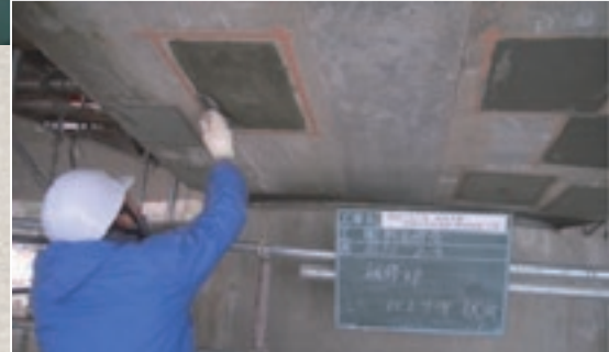
コンクリート修復施工
