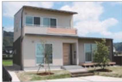
個人住宅新築工事
