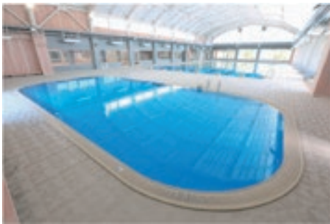
優良工事表彰(雲南市長) 海洋センター改修工事(加茂町)
