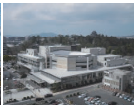
島根県民会館屋上防水改修工事
