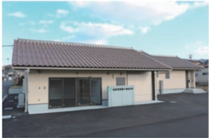
優良工事表彰(県民センター所長) 大東駐在所新築工事(大東町)
