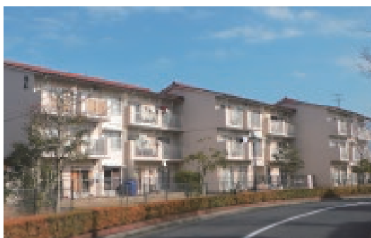
島根県営団地（松江市新古曾志団地2号棟）外壁改修工事
