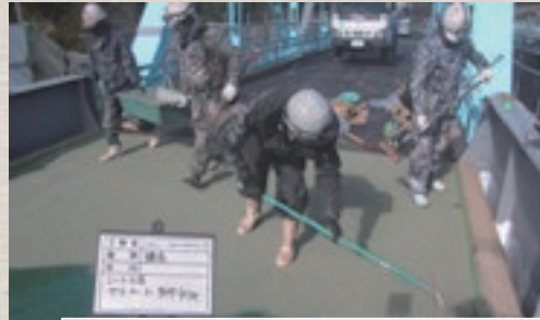
橋梁路面塗装施工
