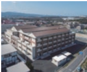
出雲養護学校改築工事
