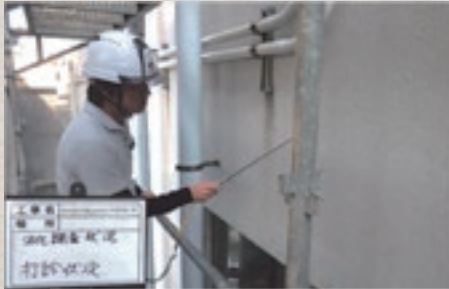
建物劣化調査
