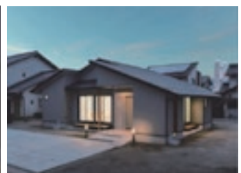
S邸新築工事
