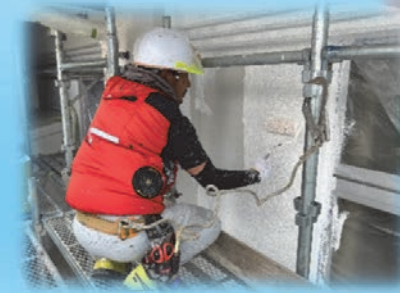
住宅塗装施工
