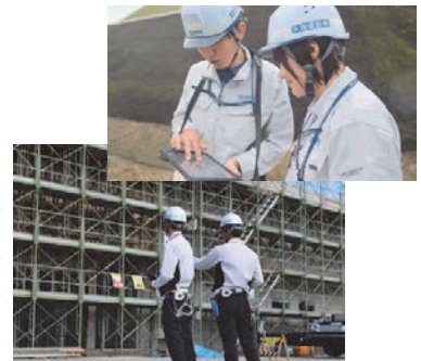
土木部・建築部の施工管理の様子
