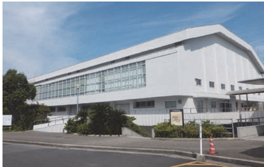
松江南高等学校長寿命化 （第一屋内運動場棟外壁改修外）工事
