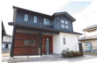
施工事例：日本の伝統色を使用した和テイストの家
