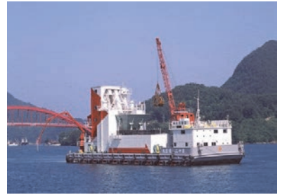
(コンクリートプラント船)
