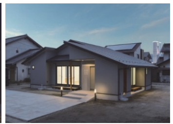
S邸新築工事
