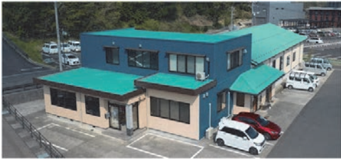
本社事務所(外観)
