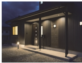
N邸新築工事
