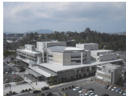
島根県民会館屋上防水改修工事
