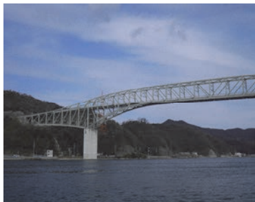
国道431号 境水道大橋 防災安全交付金（再塗装）工事
