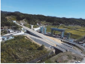
令和4年度三隅・益田道路遠田 I C第3改良工事
