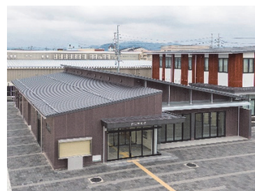
施工事例：安来市 防災研修棟
