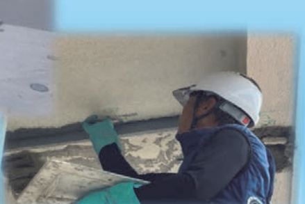
コンクリート補修施工
