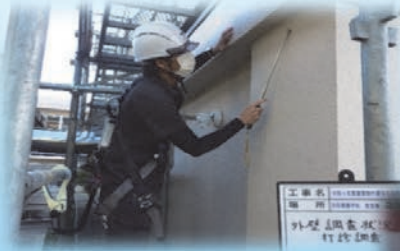
建物劣化調査
