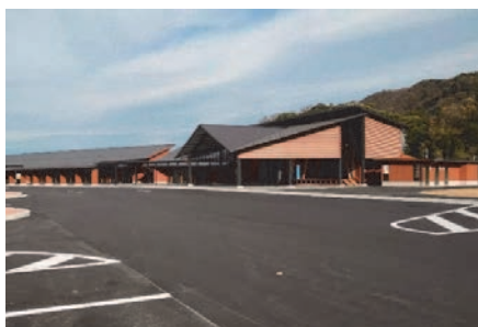
道の駅【ごいせ仁摩】機械設備工事
