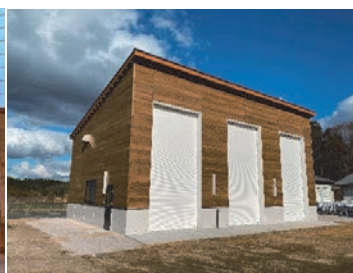
施工実績：農林大学校機械保管庫
