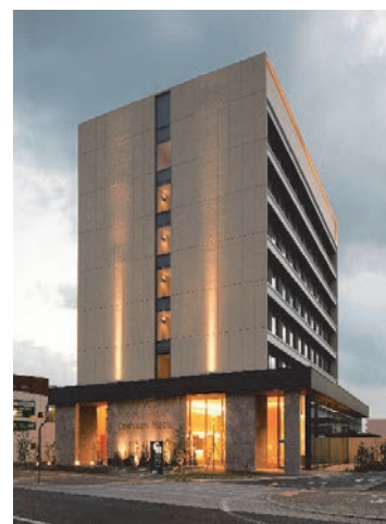
ホテル新築工事
