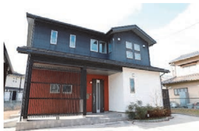
施工事例：日本の伝統色を使用したテイストの家
