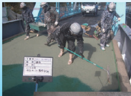
橋梁路面塗装施工
