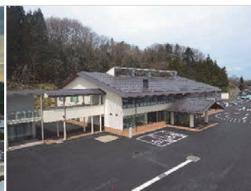
施工実績：飯南町庁舎
