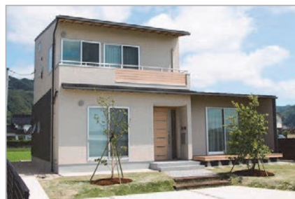
個人住宅新築工事
