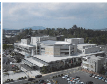
島根県民会館屋上防水改修工事
