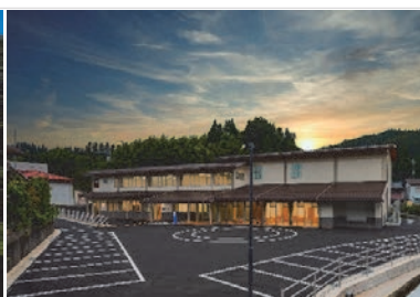
施工実績：来島交流センター
