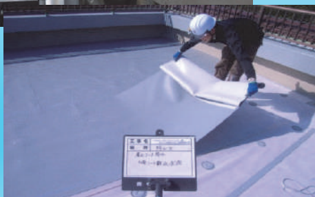
塩ビ系シート防水施工
