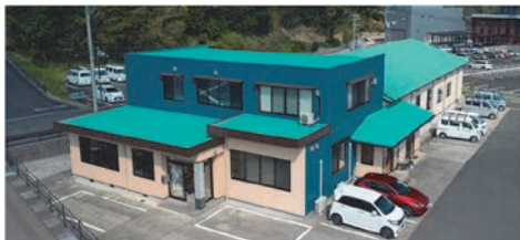
本社事務所(外観)
