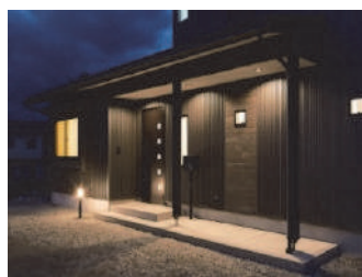
N邸新築工事
