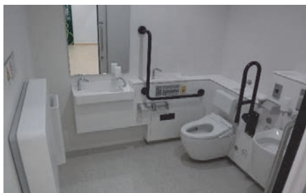
給排水設備工事
