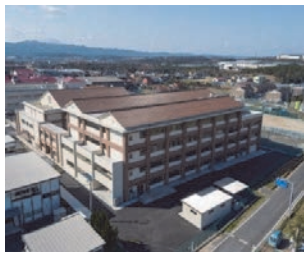
出雲養護学校改築工事
