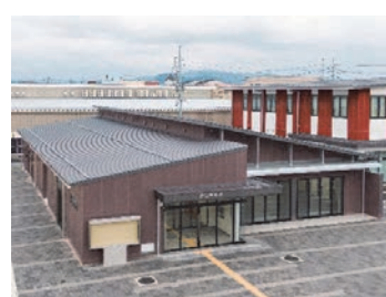
施工事例：安来市 防災研修棟
