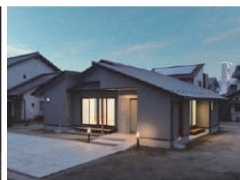
S邸新築工事
