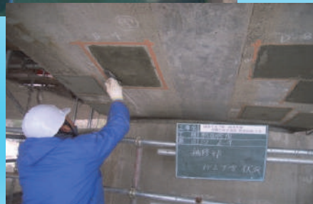
コンクリート修復施工
