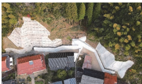
← 福浦地区急傾斜地 崩壊対策工事
