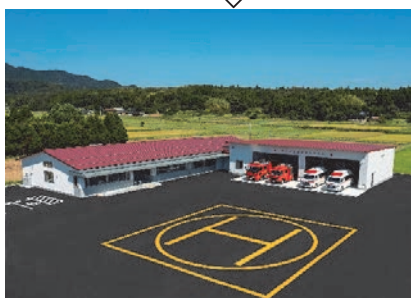
← 松江市北消防署 北部分署工事
