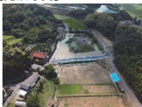
令和2年度赤松・神出堤地区 (神出堤)ため池整備工事
