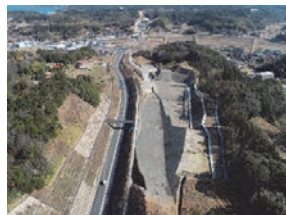
令和3年度三隅・益田道路 遠田地区第4改良工事
