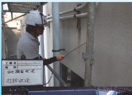
建物劣化調査
