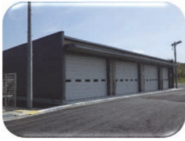
益田広域消防本部庁舎建設 (車庫棟 建築) 工事
