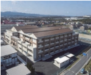
出雲養護学校改築工事
