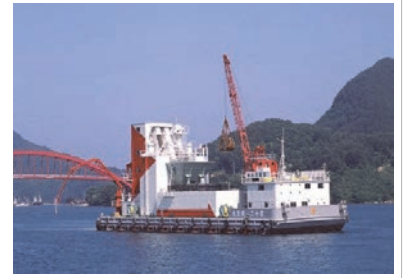
(コンクリートプラント船)
