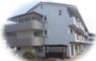
市営須子住宅2号棟長寿命化改修工事
