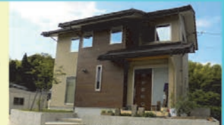
住宅新築工事
