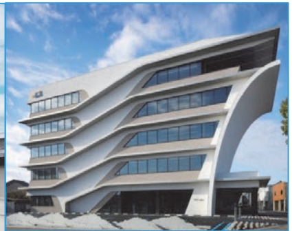
K社新築工事
