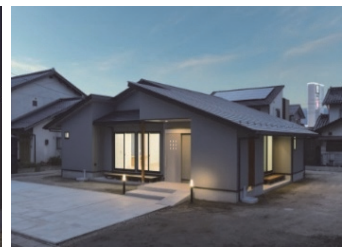
S邸新築工事
