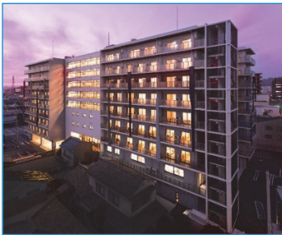
松江センターアゼリア新築工事
