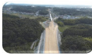
令和5年度三隅・益田道路 遠田10第4改良工事
