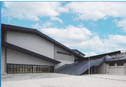
出雲市新体育館建設JV工事
